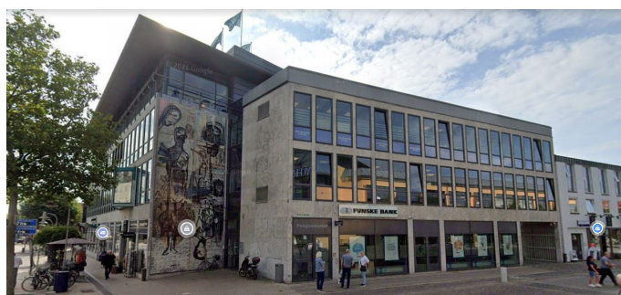
Eksisterende forhold Voldgade
